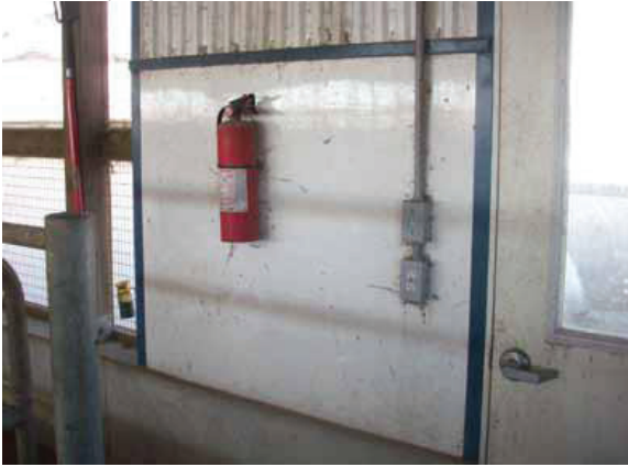
Resim 9. Yangın söndürme tüpü konumlama örneği [20]
